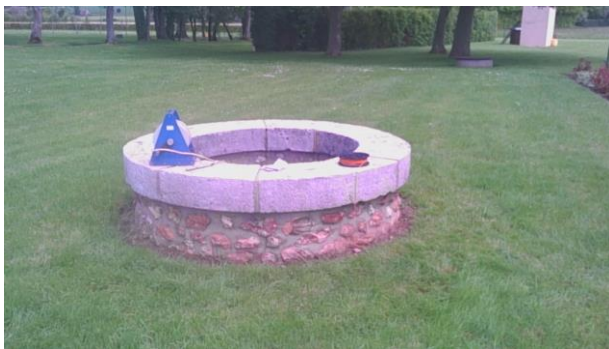
Forage « Vouzelaud » BSS000XZEG - Ouvrage artésien avec décharge à hauteur du tubage
