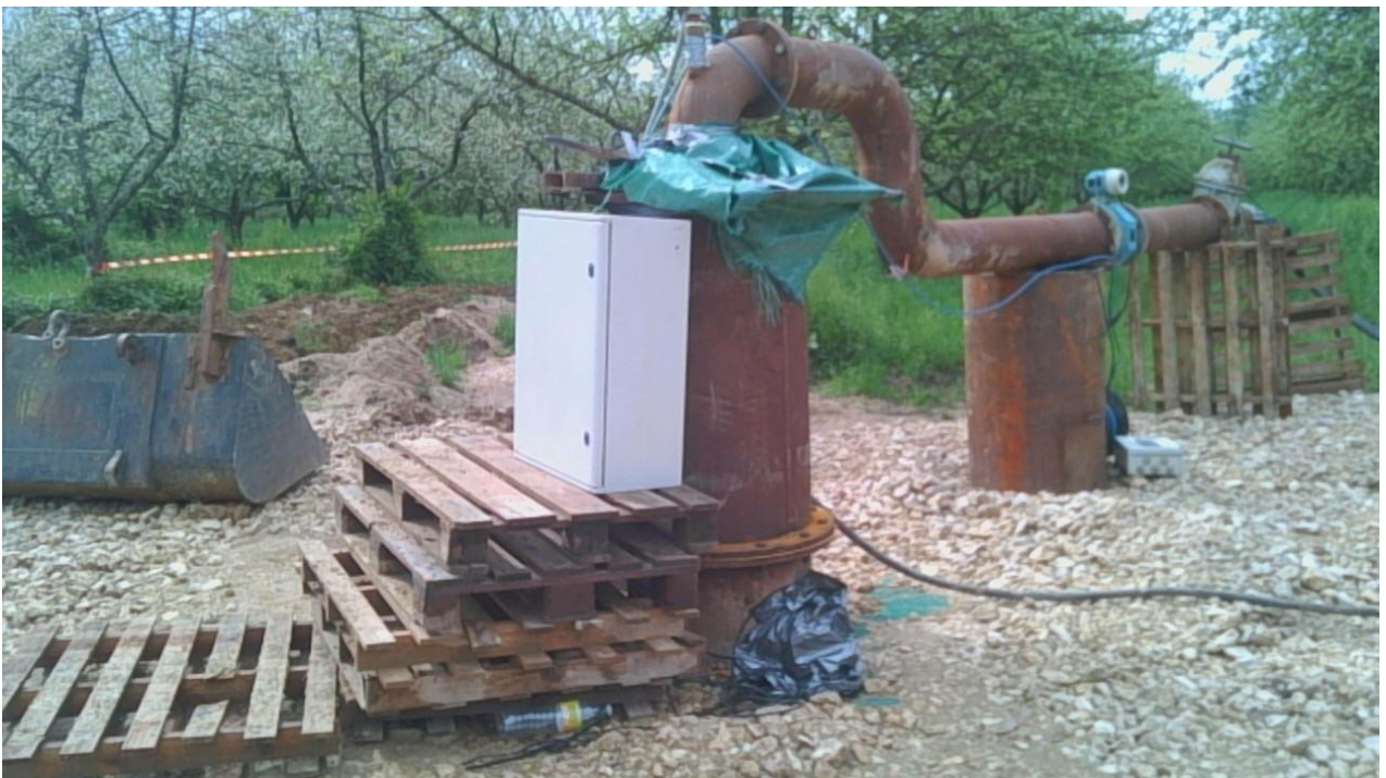
Mise en œuvre des pompes et suivi physico-chimique
