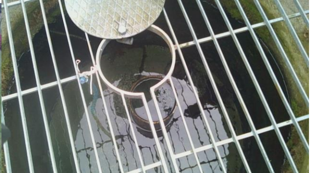
Forage « Vouzelaud » BSS000XZEG - Ouvrage artésien avec décharge à hauteur du tubage
