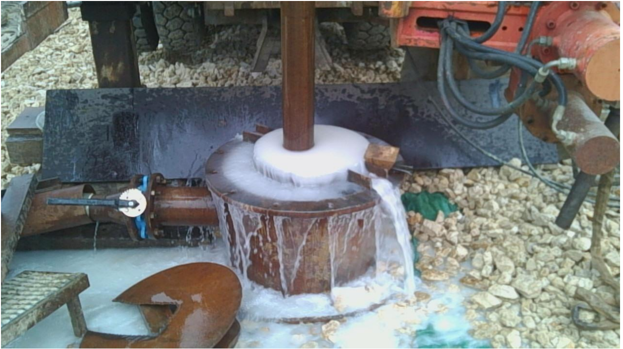
Creusement de la chambre de captage
